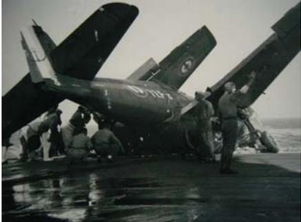
vue prise entre l'ilot et l'avion, l'aile gauche, arrachée, s'est d'abord dressée puis en pivotant se rabattait sur l'avion, le bord d'attaque vers le cockpit (où se tient le pilote !) pour, au dernier moment re-pivoter et prendre contact ... à plat ! sans pénétrer dans l'habitacle !
