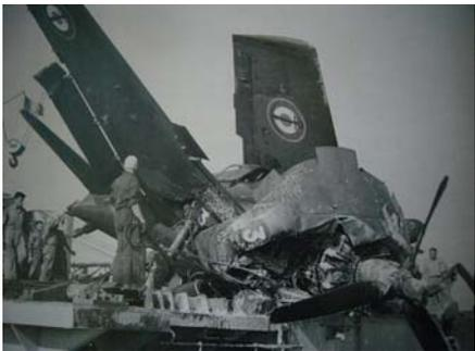
sa crosse arrachée, l'avion a continué sa course, animé par une énergie cinétique importante, au vu des dégâts occasionnés sur l'avion et sur la barrière et son support babord. L'hélice est au-dessus de l'eau.
